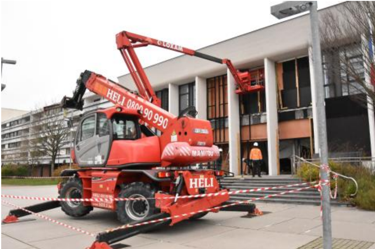
Premiers travaux de façade
