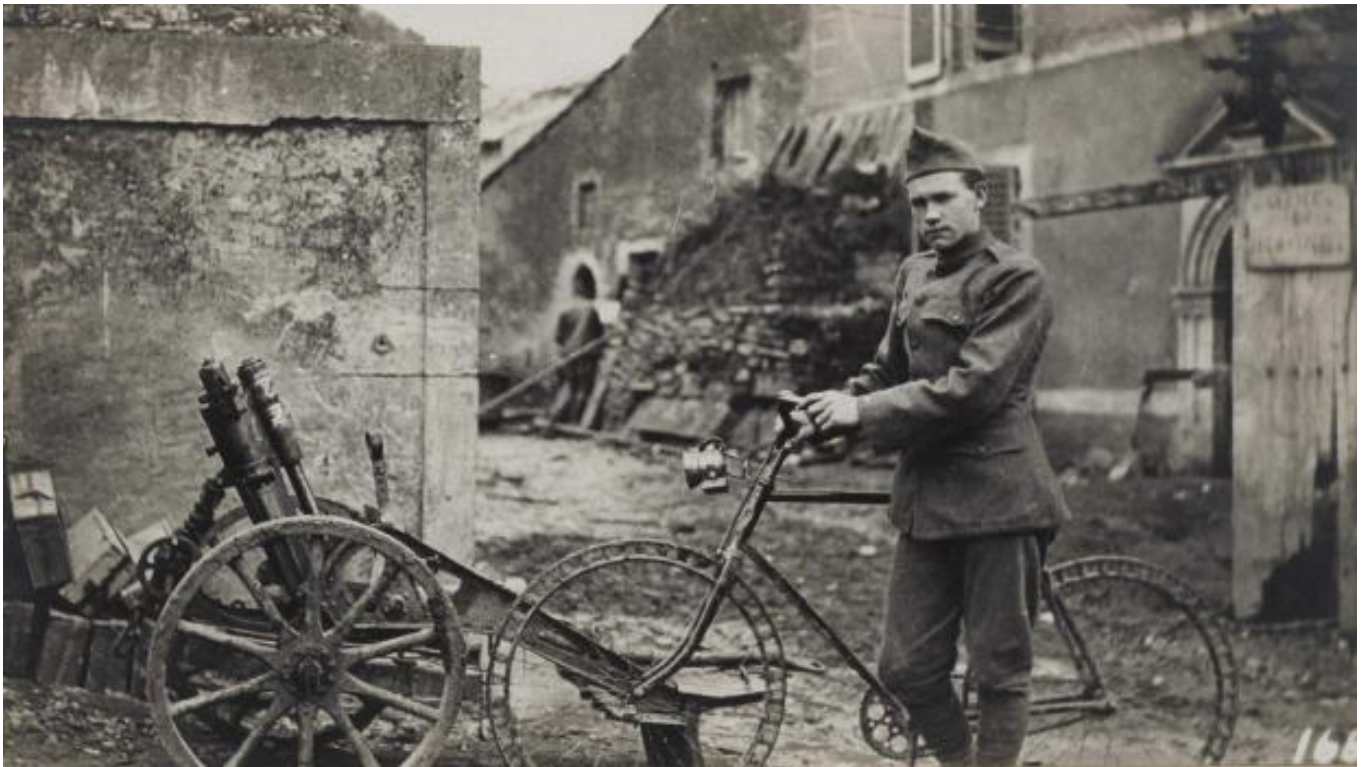
1918 - Pannes - Une rue du village reconquis en septembre 1918. Au premier plan, lance-mines allemands et bicyclette allemande aux roues sans caoutchouc #21.2
