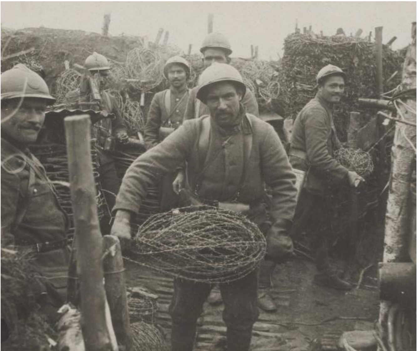
17 octobre 1916 - Lassigny - Tranchée de 1ère ligne devant le village : tirailleurs préparant les bobines de fils barbelés pour la pose des réseaux défensifs #23.1
