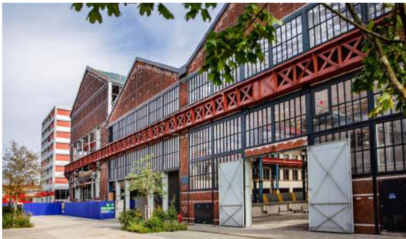
▲ Réhabilitation du site Fives-Cail à Lille
