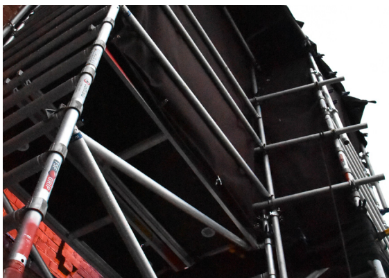
Un échafaudage recouvre une partie de la façade de la maison pour installer le matériel technique.
