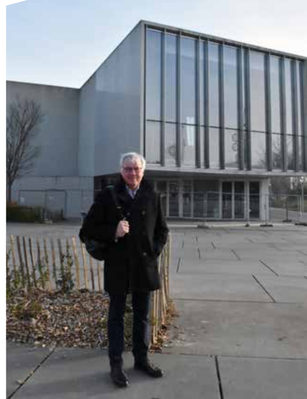
Les travaux de l'espace culturel Allende sont en voie d'achèvement. Le parvis devant la salle sera bientôt dénommé « Place Simone Veil ».
