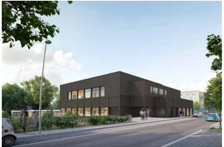
Au printemps, les travaux de construction du dojo situé boulevard Mendès-France seront lancés pour une livraison en milieu d'année 2026. Crédit illustration : @Ateleur o-s architectes
